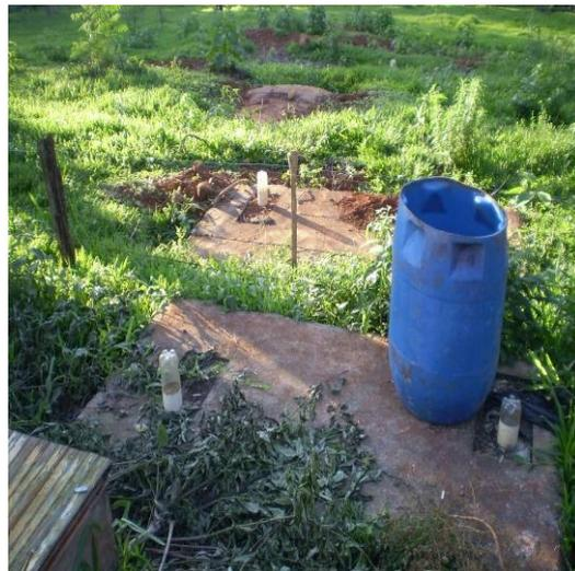
Figura 3 – Foto da Caixa de areia fechada. Decantador e caixa de gordura.
