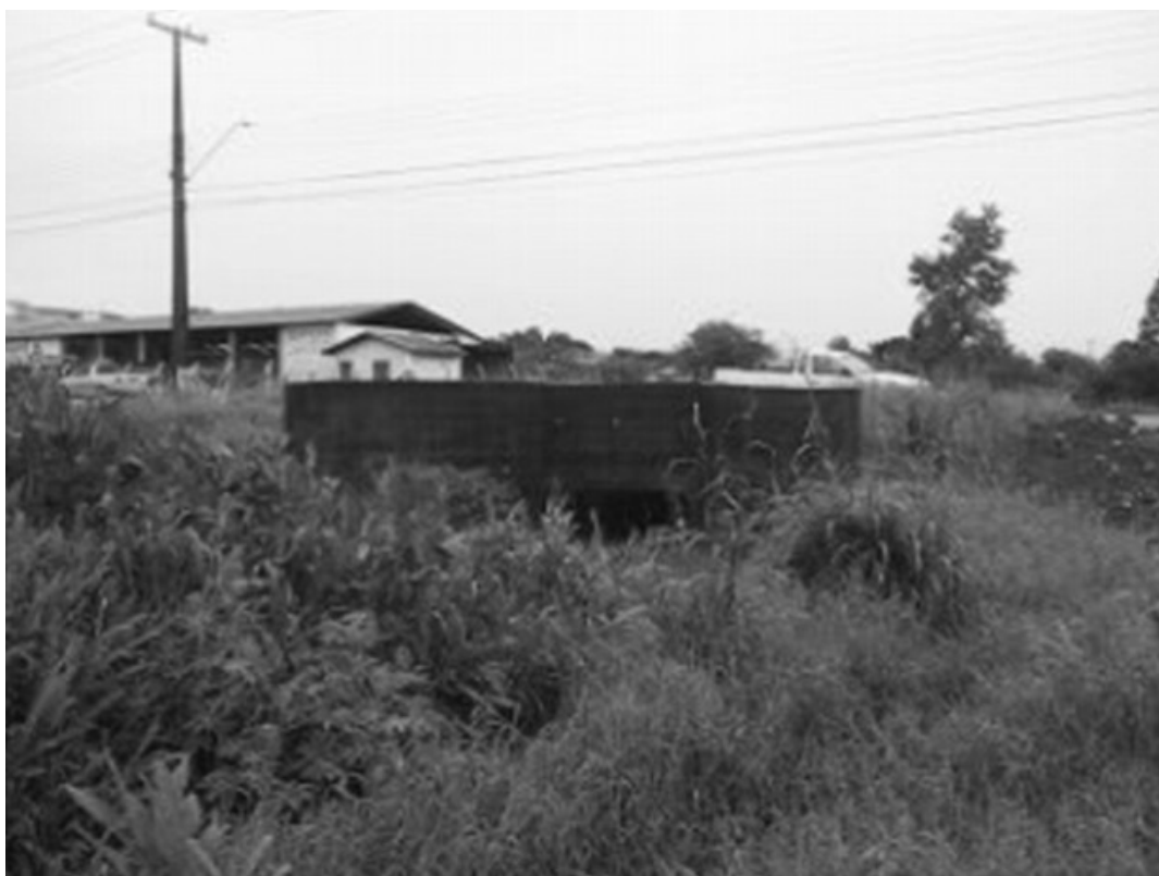
Ilustração 5: Dique de sustentação de via, bem como o extravasador e edificações, na bacia hidrográfica do Cascavel.
