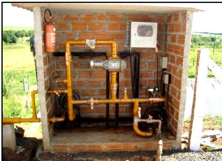
Figura 60 - Skid instalado na UGC.
