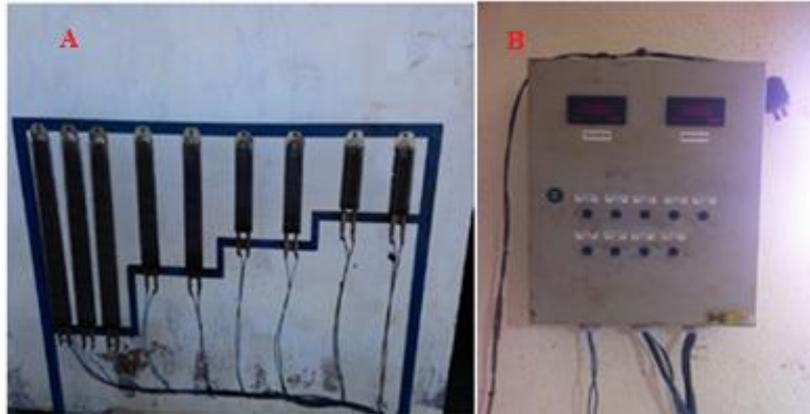
**Figura 11. (A) Banco de resistências e (B) quadro de comando.**
