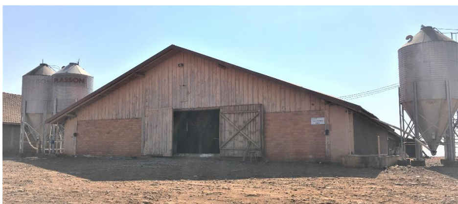
Figura 12: Fachada frontal do aviário AV1
