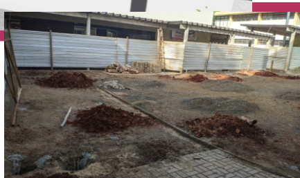
Foto: Início das obras em 07-12-2020
